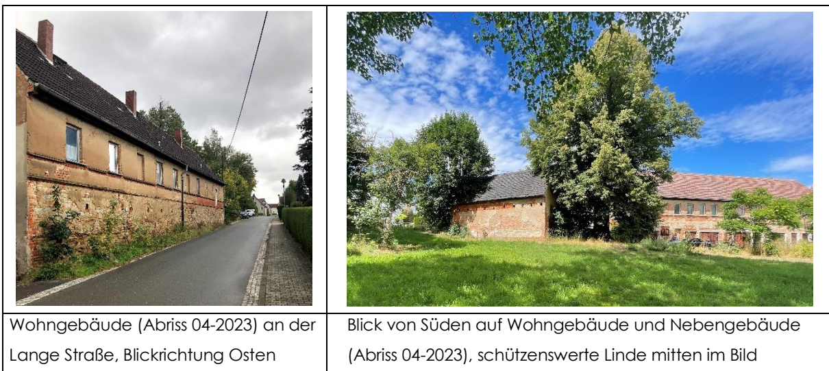
Abb. 4 | Bestandsbilder Plangebiet, Vorhabenträger, 04.05.2023
