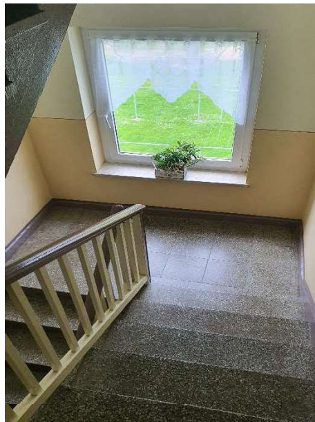
Foto 17 Blick vom Treppenhaus mit Holzgeländer auf das Fenster und Terrazzobodenpodest -älterer Standard
