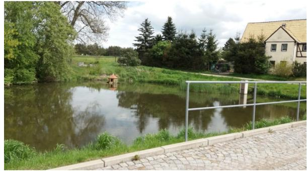
Abb.: Unvollständiges Geländer am Löschteich
