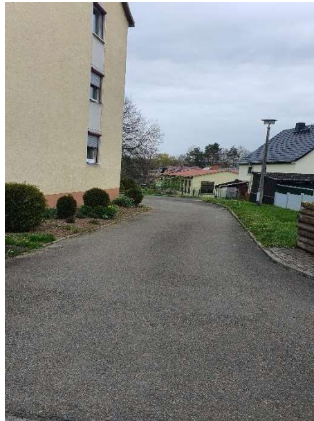
Foto 1 Seitliche Zuwegung mit Umfahrt - bitumenbefestigt
