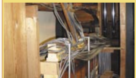
Blick ins Orgelinnere: Das Rohrleitungssystem aus dünnem Bleirohr ist 5.000 m lang.
