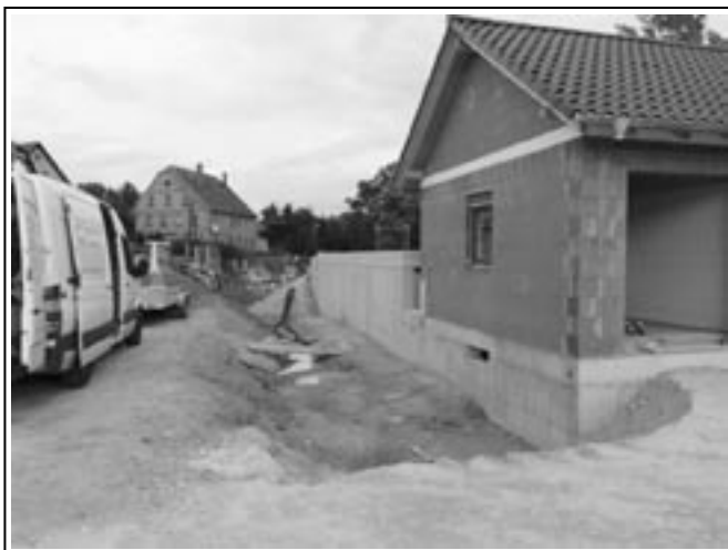
Kläranlage Großstöbnitz, Stand der Bauarbeiten vom August 2011
